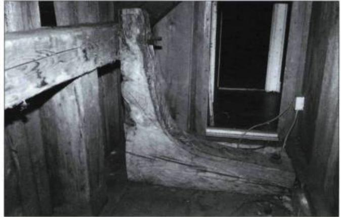
Le contreventement de la structure d'un mur avec la charpente du plancher se faisait fréquemment par des pièces de bois d'une seule venue extraites d'un tronc d'arbre à sa jonction avec les racines. Ce qui est bon pour la stabilité des arbres l'est aussi pour les charpentes d'un bâtiment!
