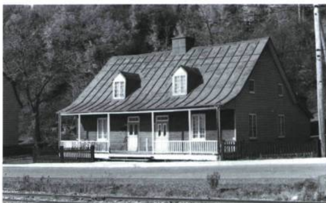
La maison Tremblay-Patterson à Beauport est une maison jumelée en bois qui possède une structure en madrier « sur le cant » (un matériau produit par la scierie Patterson) et une cheminée centrale à foyer double.
