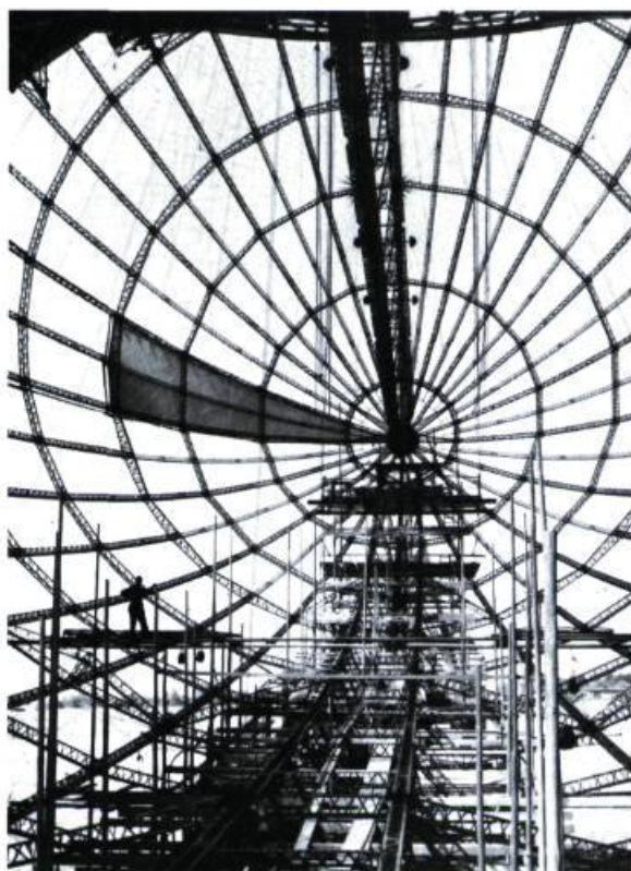
Lichtbildabteilung der Luftschiffbau Zeppelin GmbH, Cône du zeppelin Hindenburg LZ 129 vu de l'intérieur de la charpente, vers 1934. Collection de photographies du CCA.
