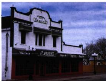
Le magasin Mailbot, une construction de type boomtown.
