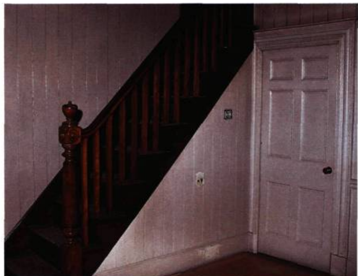
Un décor intérieur caractéristique de la fin des années 1880: un revêtement de planches emboutées avec une rainure en «V» est complété d'une plinthe et d'une corniche. Une cimaise à hauteur d'appui donne une touche élégante. Photo: François Varin.
