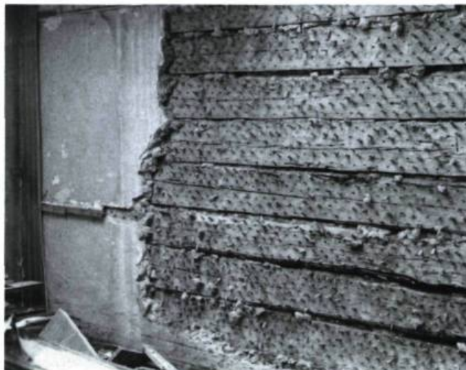
Les anciens bâtiments en pièce sur pièce étaient recouverts d'un crépi suspendu à un picotis de chevilles de bois. Ce crépi servait à la fois d'isolant et de pare-vapeur. Photo: François Varin.
