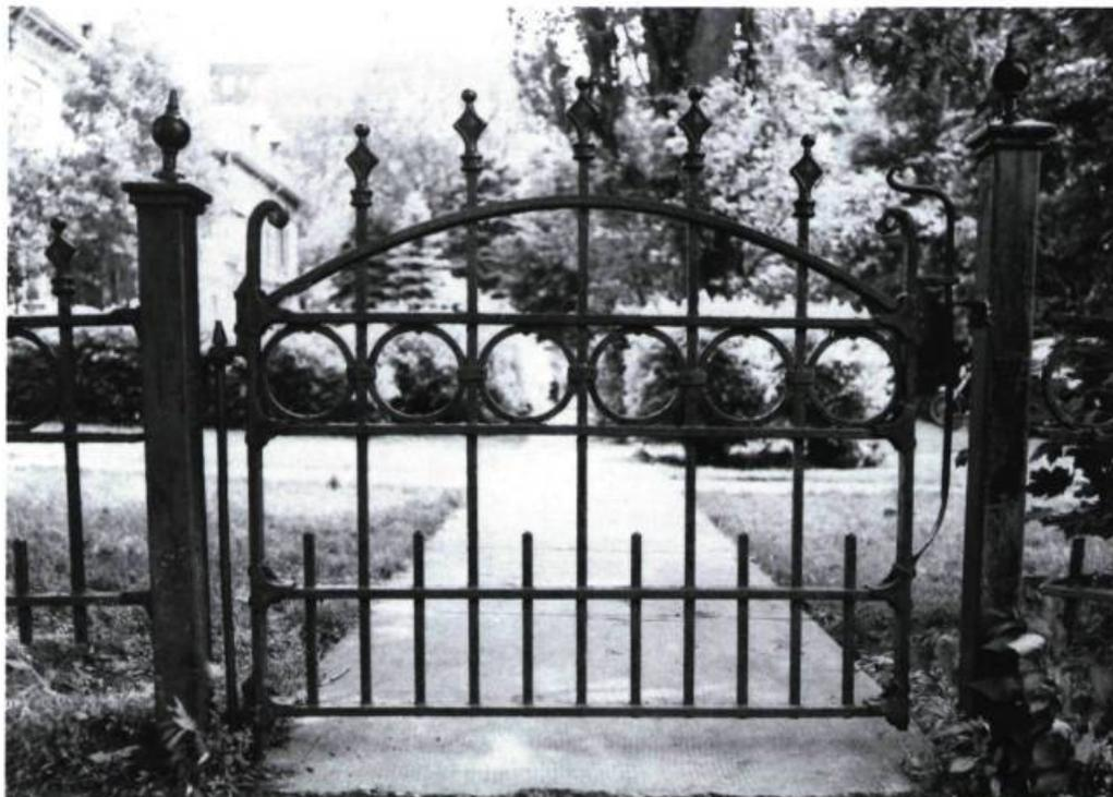
Cette clôture en fonte nécessiterait les travaux suivants: décapage, nettoyage, application d'un apprêt anti-rouille et peinture. (photo: F. Varin)
