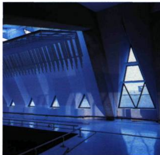
Les salles de l'étage, démesurément hautes, intègrent à la partie supérieure les fenêtres triangulaires ornées de tubulures qui jouent le rôle de déflecteurs. (photo: B. Ostiguy)
