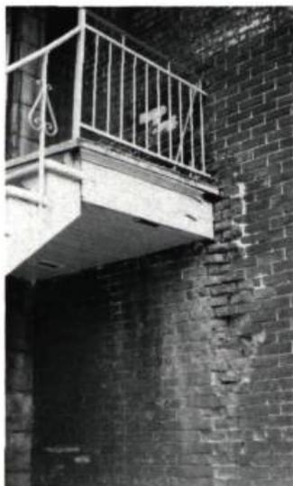
L'égouttement de l'eau sur le mur est la cause des joints évidés et des briques effritées.
