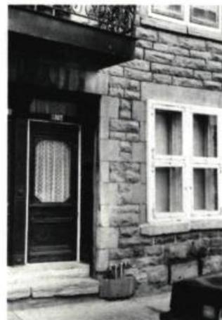
Pentes et fissures dans les éléments de maçonnerie indiquent un affaissement des fondations.
