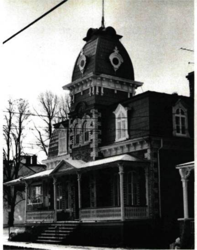
La maison Paquet (14) est typique du style Second Empire avec son toit mansard, sa tourelle et la régularité de sa composition. Son décor s'inspire de la Renaissance italienne avec ses chaînes d'angle harpées. (photo: L. Trépanier)
