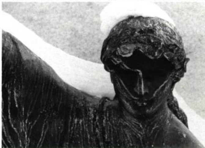
Ange affligé par la corrosion. Monument Dollard-des-Ormeaux. Parc Lafontaine à Montréal. (photo: J.R. Morissette)
