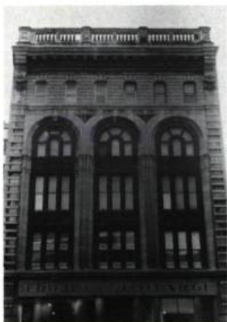
L'édifice Johargl, rue Saint-Joseph à Québec. Construit en 1904, l'édifice, dont l'architecture allie le classicisme et le nouveau style commercial américain des années 1890, est aujourd'hui un parfait candidat au recyclage. Sa complète transparence d'un axe à l'autre (mais absence de fenêtres sur les côtés) le destinerait même tout particulièrement au loft. (photo: L. Lafontaine)
