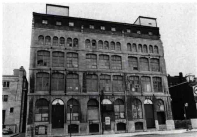
Oeuvre de l'architecte J.F. Peachy, l'entrepôt Renault (1875) s'inspire du Palazzo Itallen, évoquant ainsi le prestige de l'aristocratie capitaliste de la Renaissance. C'est la lumière naturelle qui éclairait les vastes entrepôts du XIX e siècle, ce qui explique l'abondance des fenêtres. (photo: Centre urbain de Québec)
