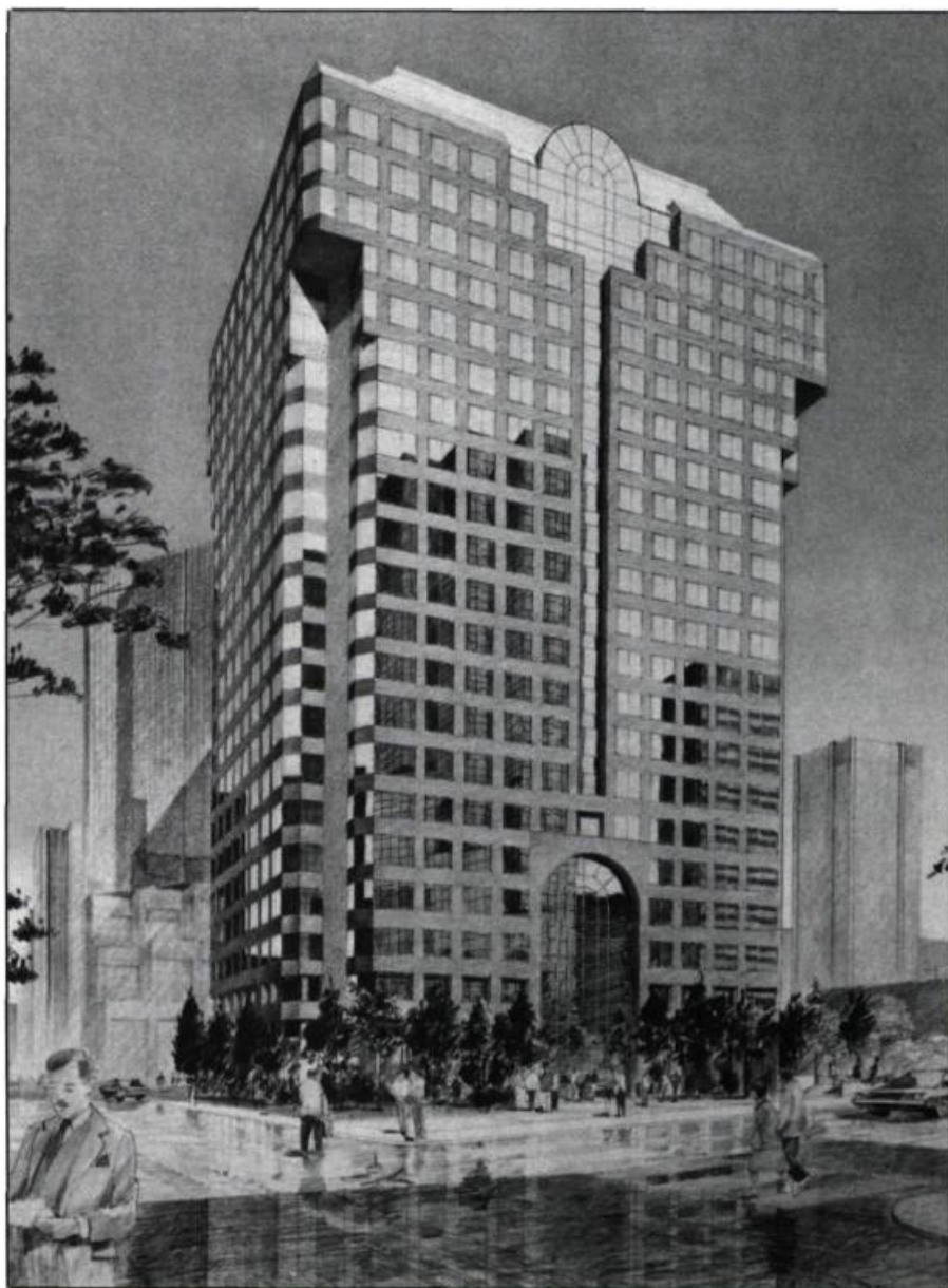
La tour de l'Industrielle-Vie en construction sur la rue McGill collége à Montréal, des architectes Tolchinsky et Goodz. La fenestration dessinée en arche, est presque devenue le symbole du post-modernisme; le revêtement de granite de la façade rappelle les premiers gratte-ciel. (dessin: Tolchinsky et Goodz)
