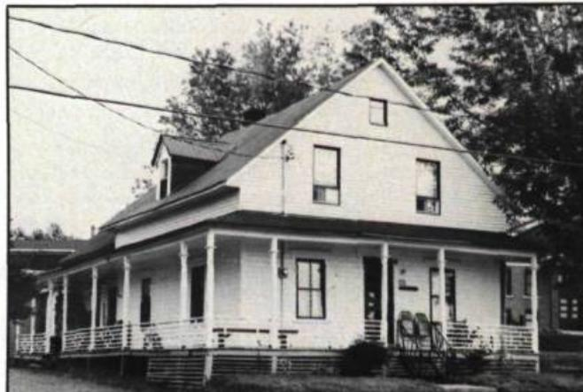
**Maison à demi-transformée permettant de voir le type de modifications que l'on réalise généralement. La planche à feuillure du rez-de-chaussée a été remplacée à l'étage par le déclin de vinyle. Les fenêtres ont perdu leurs caractéristiques permettant la datation de l'édifice. Les encadrements ont tout simplement disparu.** (photo: G. Bélanger, SPB)
