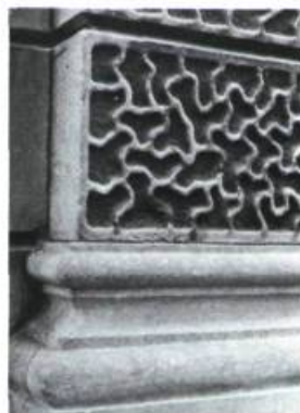
12 Une base de pilastre en pierres taillées moulurées et départ d'un pilastre en pierres taillées au décor vermiculé.
