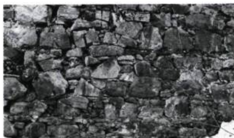
4 Appareil irrégulier où les pierres de grosseur variable et de forme irrégulière sont disposées librement sans alignement ou régularité.
