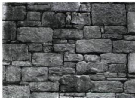
4 Appareil irrégulier où les pierres de grosseur variable et de forme irrégulière sont disposées librement sans alignement ou régularité.
