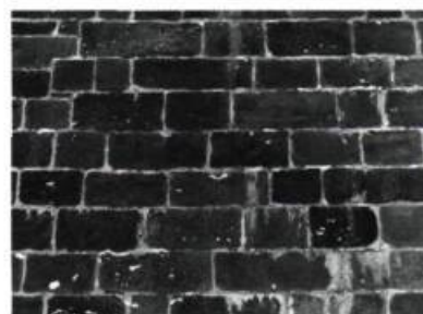
8 Appareil à assises régulières: les pierres taillées de longueur variable sont disposées par assises ayant plus ou moins la même hauteur.
