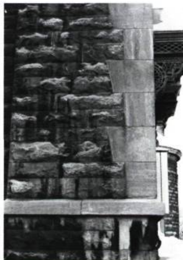
11 Chainage d'angle de pierres taillées qui affirme la verticalité et la solidité de la construction.
