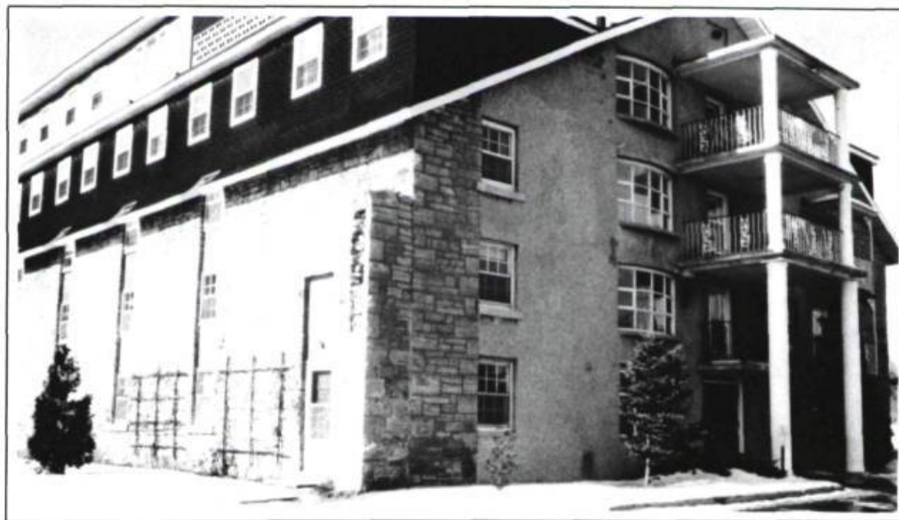
Le bâtiment reconverti en 1982.
