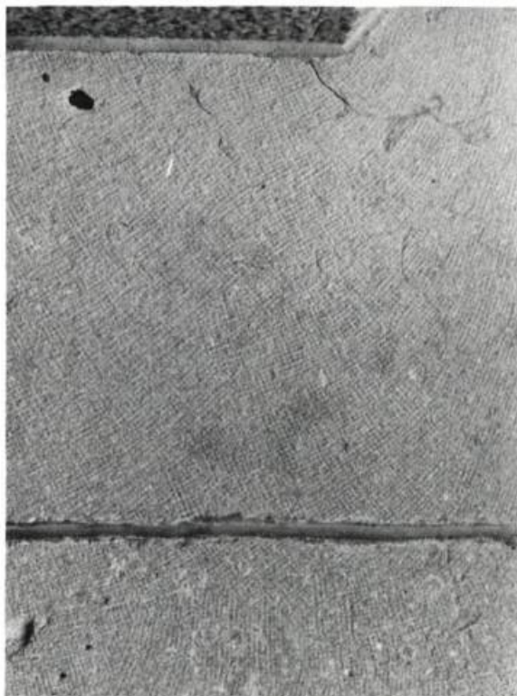
C Un nettoyage approprié devrait conserver toutes les marques de l'outil utilisé pour la taille de la pierre; ces marques témoignent de l'âge et de l'histoire du bâtiment.
