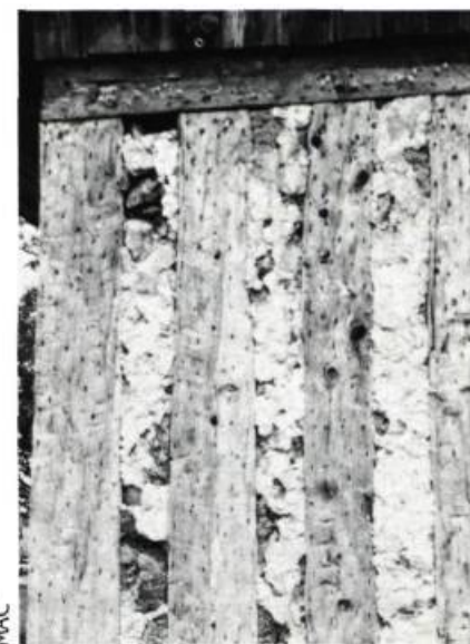
La technique du colombage pierroté
