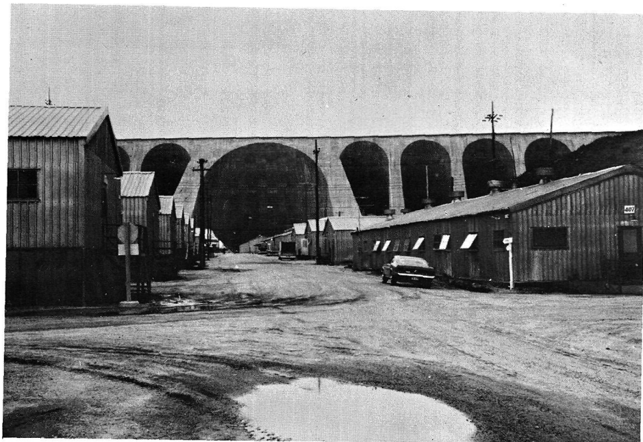
Photo 1 Le chantier de Manic 5.
