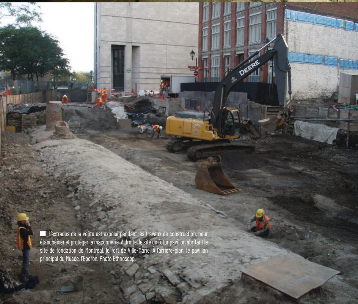
■ L'extrados de la voûte est exposé pendant les travaux de construction, pour étanchéiser et protéger la maçonnerie. À droite, le site du futur pavillon abritant le site de fondation de Montréal, le fort de Ville-Marie. À l'arrière-plan, le pavillon principal du Musée, l'Éperon. Photo Ethnoscop.
