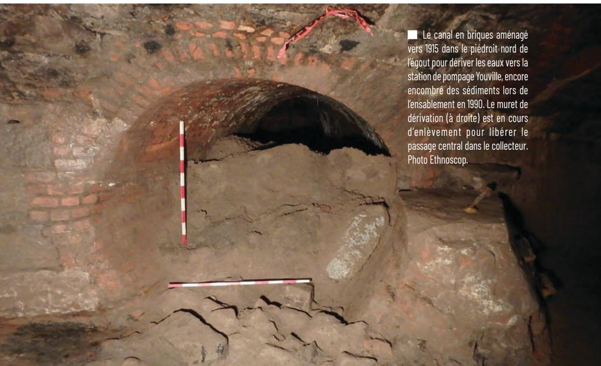
■ Le canal en briques aménagé vers 1915 dans le piédroit nord de l'égout pour dériver les eaux vers la station de pompage Youville, encore encombré des sédiments lors de l'ensablement en 1990. Le muret de dérivation (à droite) est en cours d'enlèvement pour libérer le passage central dans le collecteur. Photo Ethnoscop.
