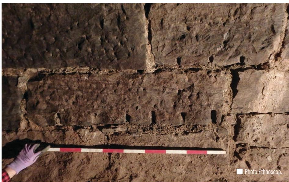
L'égout collecteur mesure près de 4,30 m de largeur au sommet des piédroits. Sa hauteur fluctue cependant beaucoup : alors qu'à l'ouest (la partie construite en 1832) il fait 3 m de hauteur, à l'est la voûte est par endroits affaissée et mesure à peine 2,10 m de hauteur.
