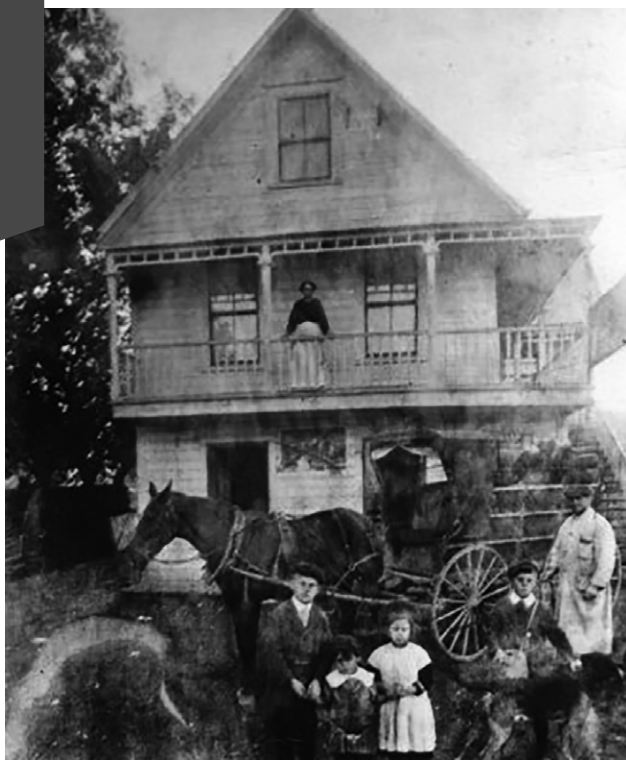
La boulangerie Cossette en 1913. On y voit Joseph Cossette entouré de sa famille. C'est ce bâtiment qui a été démoli dans les années 1940. (Coll. Famille Cossette).
