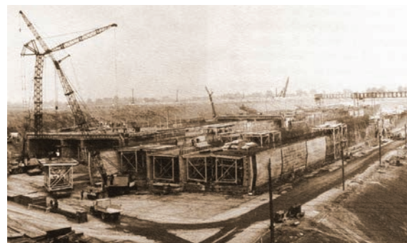
Pont-tunnel Louis-Hippolyte-La Fontaine, 1964-1967. Cette œuvre monumentale, réalisée en moins de trois ans et demi, est, à cette époque, l'infrastructure routière la plus considérable construite en béton précontraint dans le monde. (Archives du ministère des Transports du Québec).
