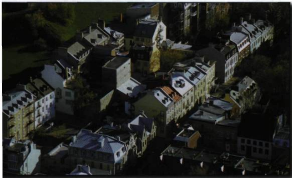
L'îlot des avenues Saint-Denis et Sainte-Geneviève, un lotissement du XVIII e siècle mais construit dans la première moitié du XIX e siècle. Photo Pierre Lahoud.
