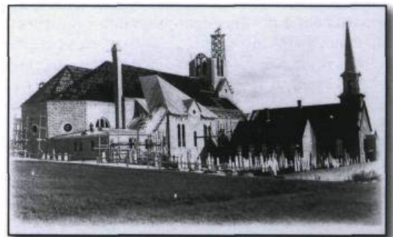
Construction de la nouvelle église d'Armagh dans Bellechasse, en 1933. Armagh est un comté de l'Irlande. Carte postale, fonds Magella Bureau. (Bibliothèque et Archives nationales du Québec, P547 S1 SS1 SSS1 D15).
