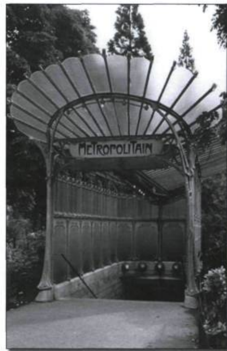
Entrée du métro de Paris, œuvre de l'architecte Hector Guimard. (Collection de l'auteure).
