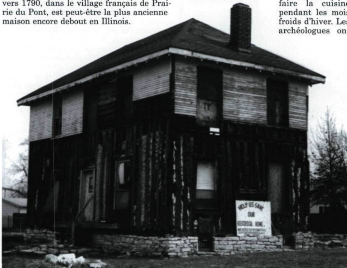
La Maison Martin-Boismenu, datant de 1790, telle que vue dans les années 1980 lorsque cette structure presque intacte en poteaux sur sole a été découverte sous le revêtement extérieur plus moderne. Le toit d'origine a été enlevé lors de l'addition d'un deuxième étage, en 1913. (Prairie du Pont Preservation Society).
