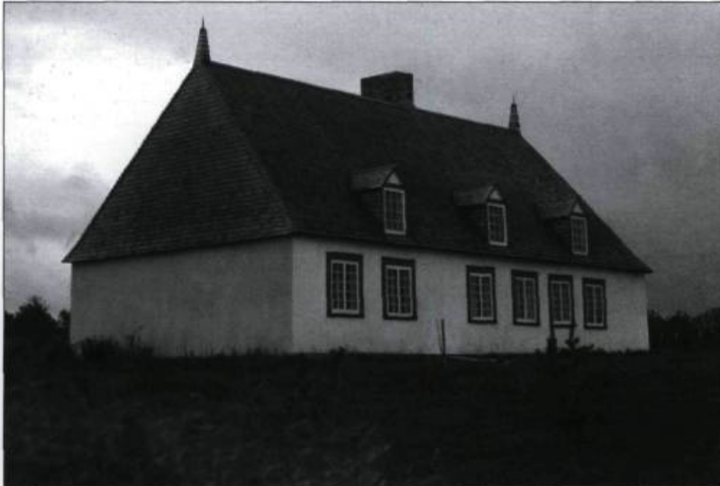
«Maison Sifroy Roy, Beaumont dans le comté de Bellechasse, vers 1720». Le bâtiment à quatre versants agrémentés d'épis a été construit en pièce sur pièce. L'extérieur est recouvert de planches à la verticale et l'intérieur, fini au crépi sur «picotis» de chevillettes. Plus de 80 % des maisons rurales du Régime français étaient élevées en bois. Photographie de Michel Lessard. (Archives de l'auteur).
