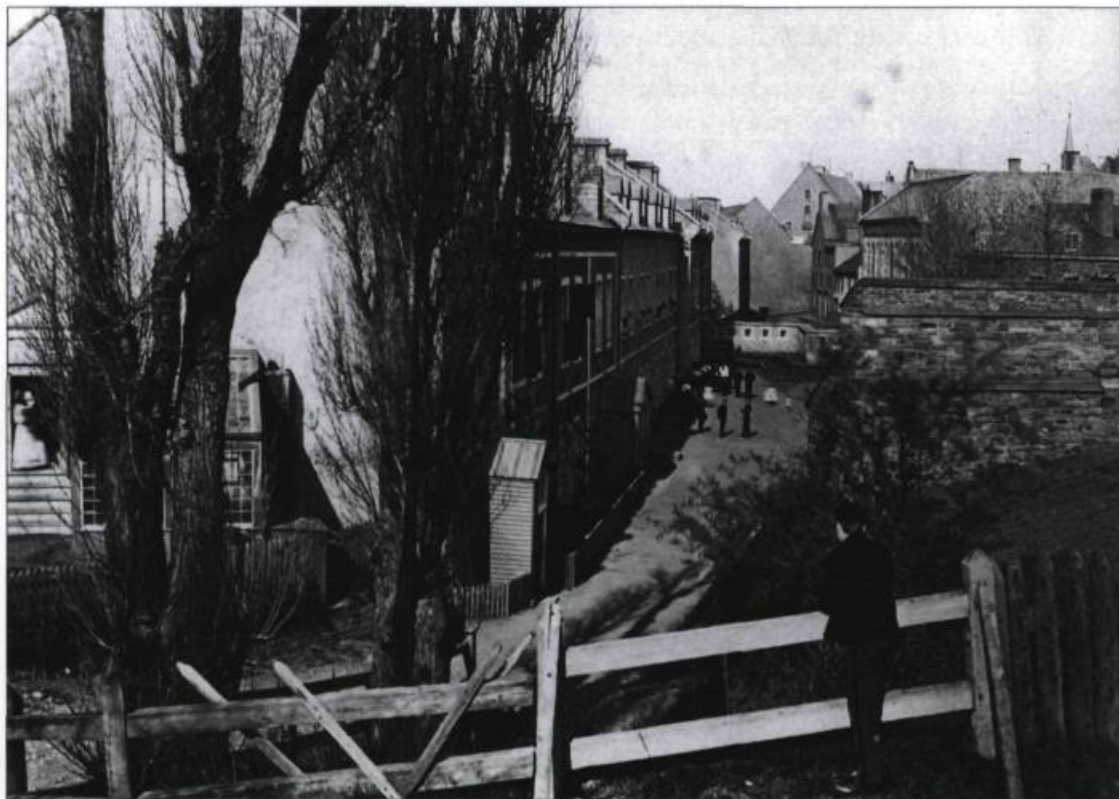
Les Nouvelles Casernes vues du demi-bastion du coteau de la Potasse. L'extrémité ouest de l'édifice, épargnée par l'incendie de 1851, présente toujours certaines caractéristiques du classicisme français qui soulignent en façade les divisions intérieures de l'édifice. La photographie, prise à la veille du départ de la garnison britannique, en 1871, illustre aussi la section non reconstruite de l'édifice, en 1852. Photographie de Livernois et Bienvvenu. (Archives nationales du Québec, à Québec).
