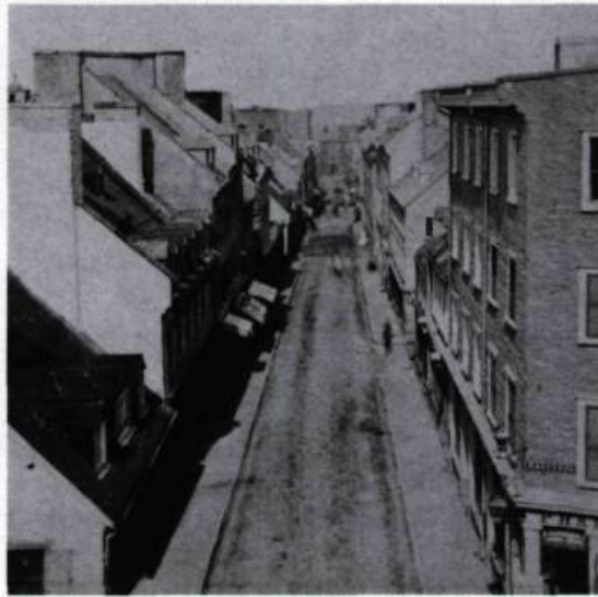
«La rue Saint-Jean, hier et aujourd'hui». Les façades refaites de certaines constructions de la rue Saint-Jean. On voit bien les cheminées qui sont artificiellement reléguées près du mur gouttereau. On a ainsi corrigé l'alignement de la rue au XIX e siècle. Photo: Louis Prudent Vallée vers 1875. Photo: Yves Beaugard, 1995. (Coll. Yves Beaugard).
