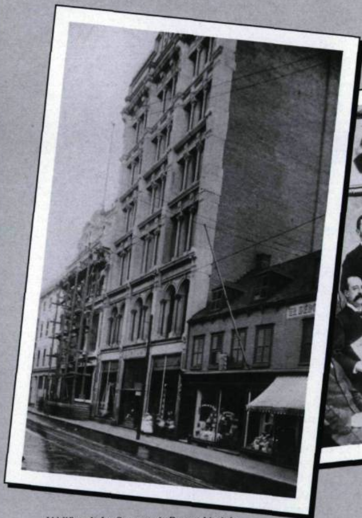
L'édifice de La Compagnie Paquet Limitée. La façade est animée de larges vitrines au niveau du trottoir et de rangées de baies à colonnes aux étages, le tout selon une articulation toute classique des éléments d'architecture. (Fonds Raoul Chênevert. Archives nationales du Québec à Québec).
