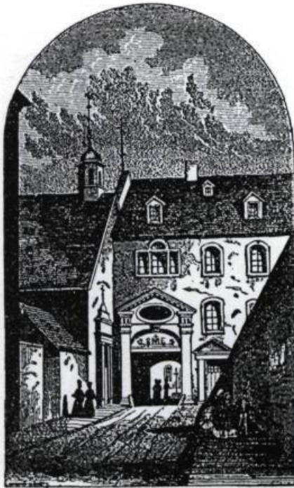
Porche de l'aile de la Congrégation vers 1858-1859. Du côté gauche, on voit la chapelle du séminaire construite en 1750-1752 et détruite par un incendie en 1888. (Collection Yves Beauregard).
