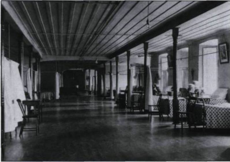
Cette photographie de R. Traquair (1928) montre la salle du premier étage de l'aile de la façade (1714-1950). (Archives du Monastère des Augustines de l'Hôpital Général de Québec).
