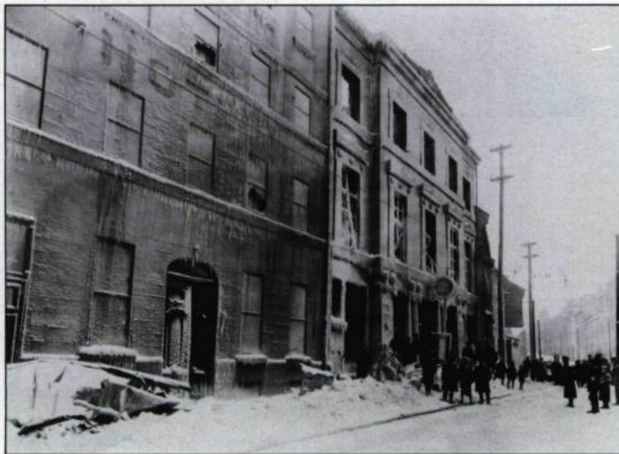
Érigé en 1851-1852, selon les plans de l'architecte Charles Baillairgé, l'édifice du Music Hall s'inspire du style Greek Revival caractérisé par la présence de colonnes doriques, rosettes et têtes de lion. (Archives nationales du Québec, Collection initiale).
