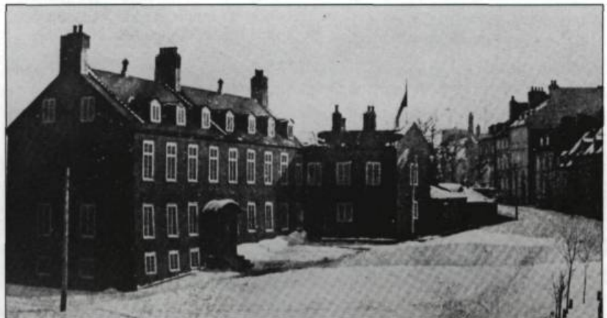
Aile du «Vieux Château» qui abrita l'École Normale Laval de sa fondation jusqu'à sa relocalisation dans le faubourg Saint-Jean-Baptiste. Les Noces d'Or de l'École Normale Laval. 1907.
