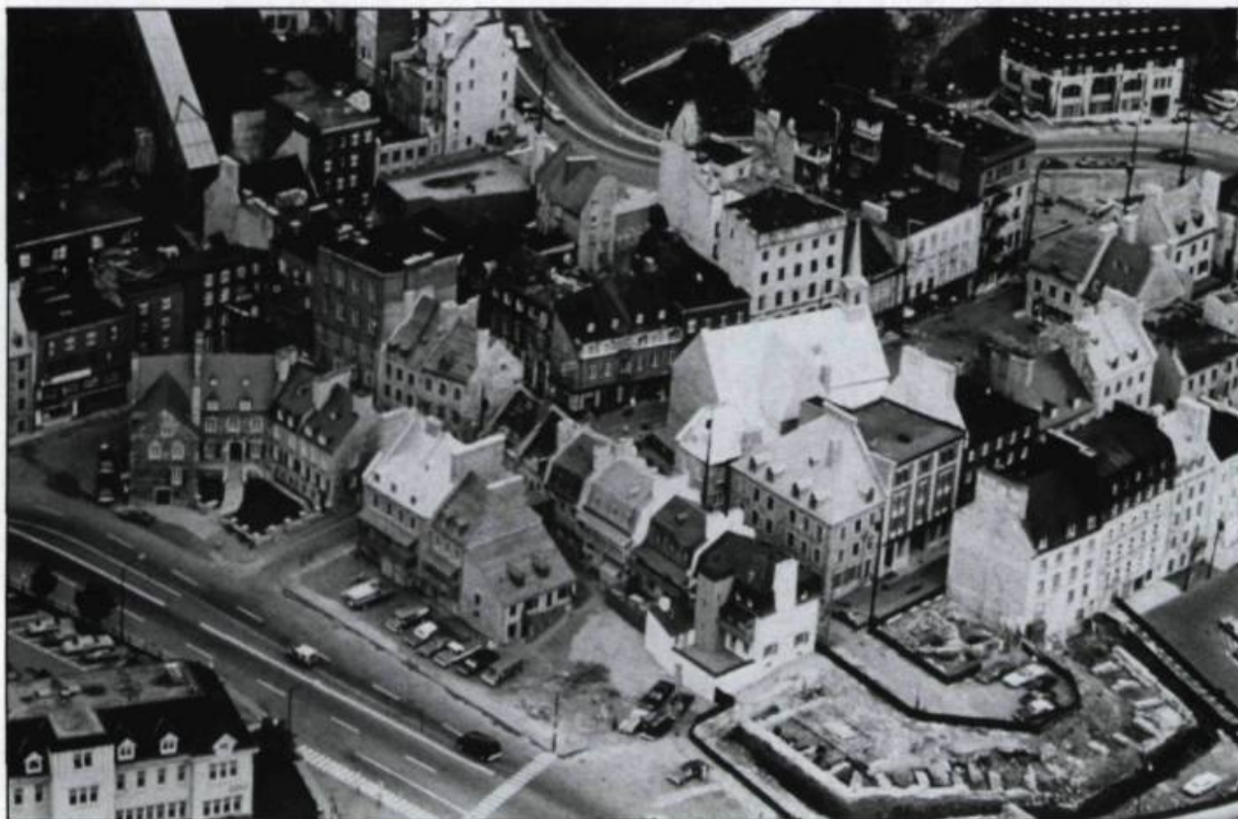
Vue aérienne de la batterie royale construite en 1691 sur l'ordre du gouverneur Frontenac. Photo prise lors de la restauration en 1975. (Photo: Ministère des Communications du Québec).
