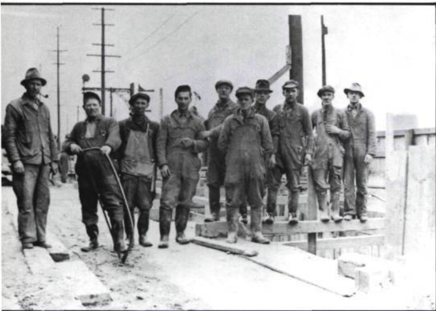
Groupe de travailleurs affectés à la construction de l'égout collecteur dans la décennie 1930. Archives de la ville de Québec.
