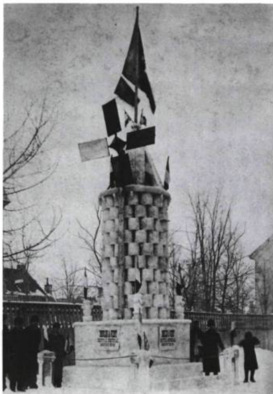
Les pompiers de Saint-Sauveur ont également tenu à décorer leur coin de quartier. Ils ont érigé une réplique du moulin à vent que firent construire les dames de l'Hôpital Général en 1710. D'une hauteur de 30 pieds, ce moulin en blocs de glace ronds était illuminé de l'intérieur. Archives nationales du Québec.
