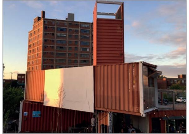
ILL. 14. LE VIRAGE ET LA CONTINUITÉ DES ARCHITECTURES. | JONATHAN CHA.
