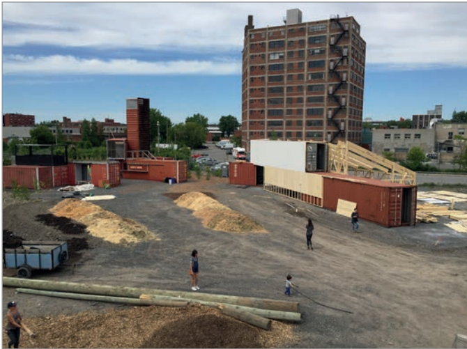
ILL. 23. LE GRAND HALL DU VIRAGE EN CONSTRUCTION ET L'ÉVOLUTION DES SURFACES AU SOL. | JONATHAN CHA.
