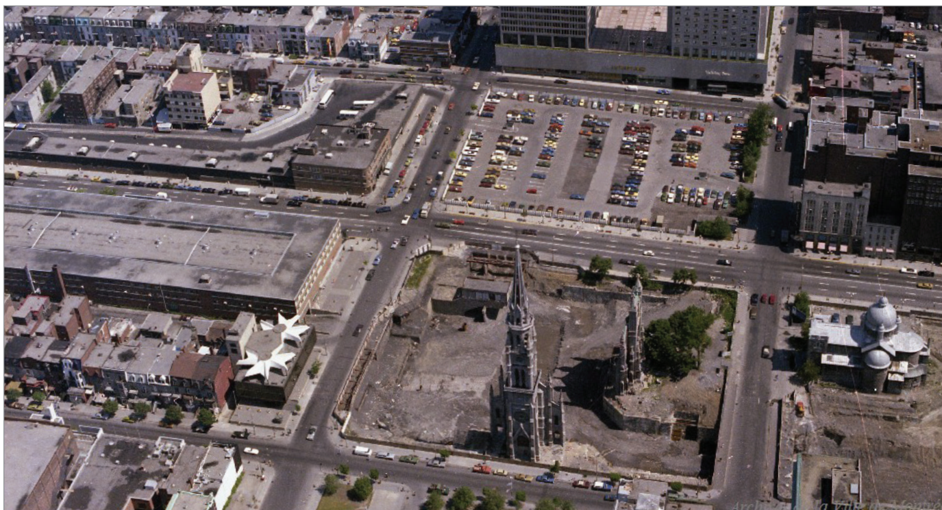
ILL. 18. ÉGLISE SAINT-JACQUES ET CHAPELLE NOTRE-DAME-DE-LOURDES APRÈS LES DÉMOLITIONS (9 JUI 1976). | VINCENT MASSARO. SOURCE : ARCHIVES DE LA VILLE DE MONTRÉAL.
