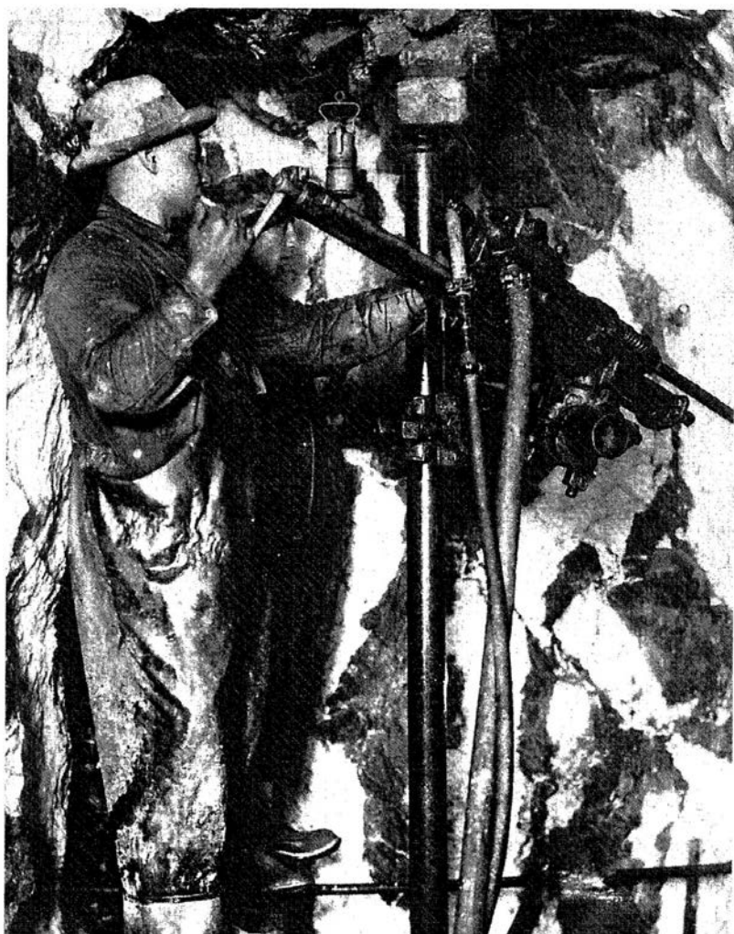
Foreur et aide-foreur. Le foreur et l'aide-foreur à l'oeuvre dans une mine d'or de Timmins. On distingue très nettement les boyaux d'air et d'eau qui alimentent la foreuse. Ces deux travailleurs font équipe: l'aide-foreur, en arrière-plan, apprendra les rudiments du métier au gré de leurs conversations et à force de voir le foreur agir. Sudbury, Centre Green Miller, Bibliothèque des mines, (Archives publiques du Canada, PA 17429).
