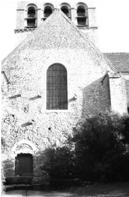
Bras nord du transept auquel était accolée une chapelle dédiée à saint Nicolas. Source : Katerie Gaudet-Chamberland
