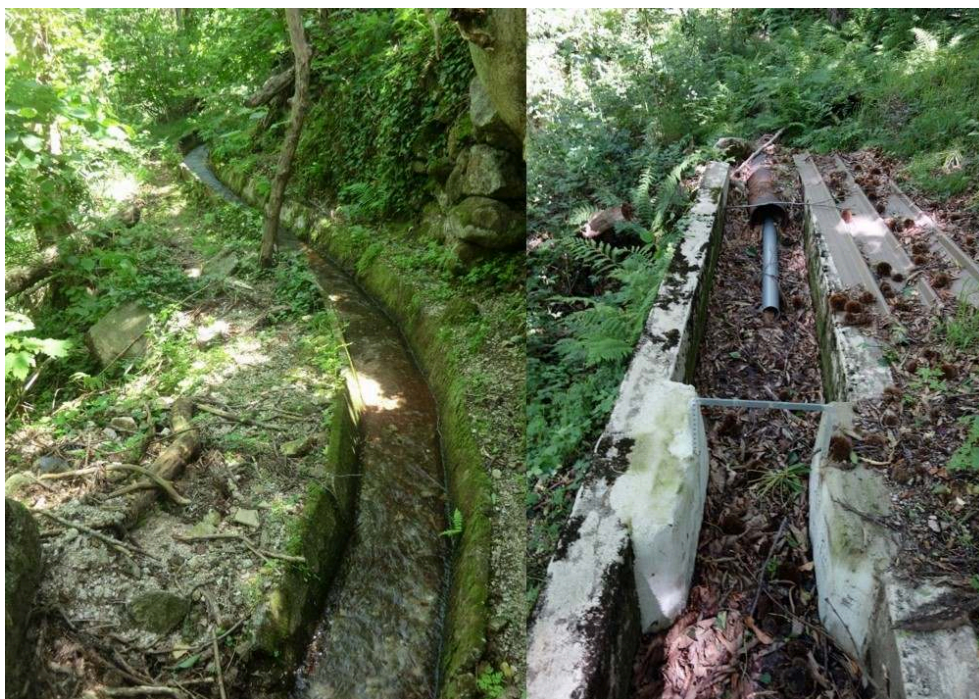
4a. Le béal des Chambons à ciel ouvert et revêtu de buses en béton », 4b. Le béal des Plots illustre différentes phases de modernisation technique : pose d'un tuyau, construction du tronçon en béton pour la mesure du débit, ancien emplacement d'une vanne crantée, canal enterré.
