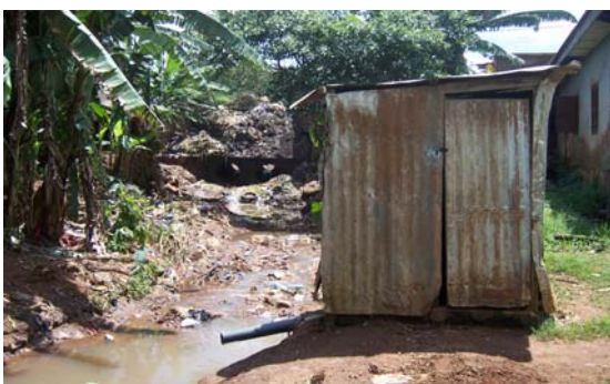
Figure 8. Latrine munie d'un tuyau du « trop plein »
