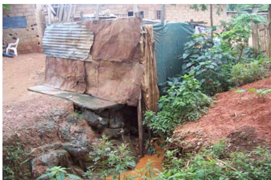
Figure 7. Latrine à canon sur l'Abiergué.
