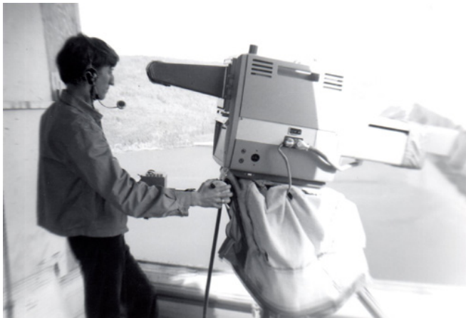
Photo 6 Une des trois caméras de télévision qui transmettaient des images en direct du chantier de Manic 5 à Montréal, au site de l'Expo 1967 (Photo Pierre Lepage, 1967)
