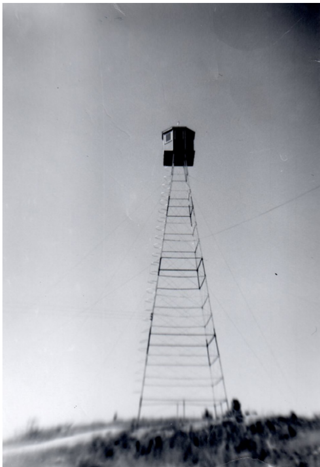
Photos 4 et 5 Tour Manic 5 située sur la montagne à l'ouest du barrage, et vue imprenable sur l'immense lac artificiel de 800 milles carrés en amont de l'ouvrage (Photos Pierre Lepage, 1967)
