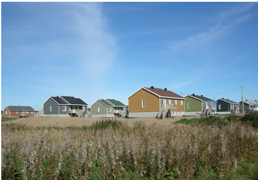
Photo 6 Nouvelle rue de la réserve, septembre 2013 (Photo : Aude Maltais-Landry)
