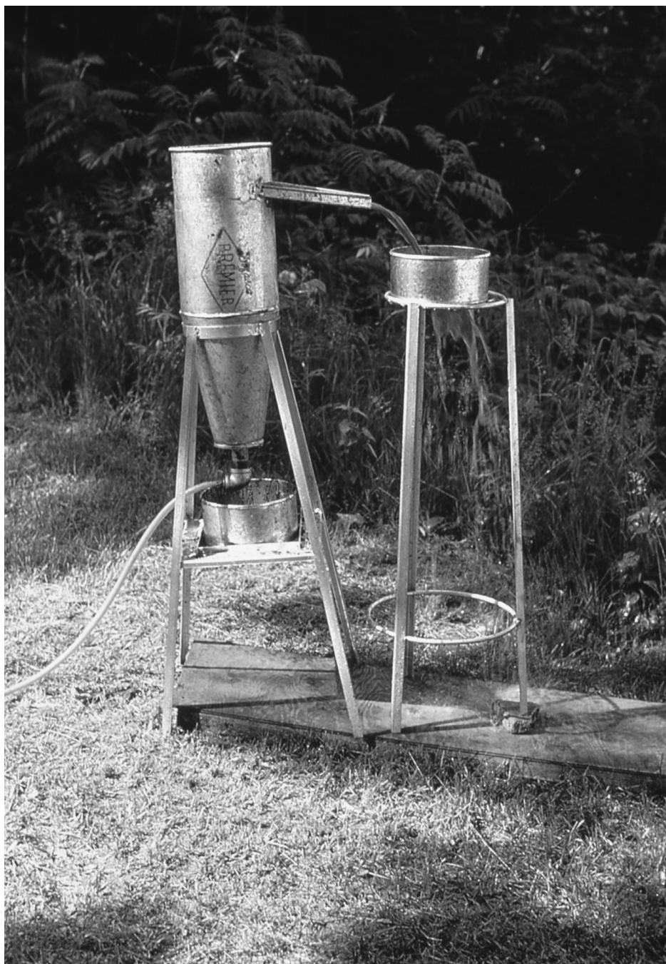
Colonne à élutriation, une méthode de tamisage à l'eau qui a permis de recueillir des particules fines comme des éléments d'origine végétale ou animale, lors des fouilles, en 1971
