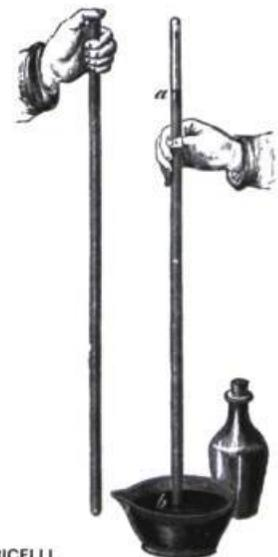
LE BAROMÈTRE DE TORRICELLI
