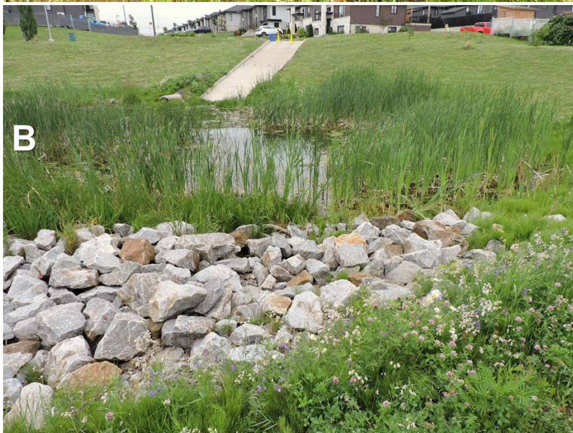
Figure 10. Bassins de rétention des eaux pluviales: A) bassin des Pigamons dans l'arrondissement de Charlesbourg de la ville de Québec; B) bassin des Prés du Saint-Rosaire dans la ville de Rimouski.
