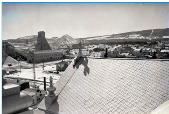
ILL. 17 (GAUCHE). MINE KING, VUE DU TOIT DE L'ÉGLISE SAINT-ALPHONSE, 1965. CENTRE D'ARCHIVES DE LA RÉGION DE THETFORD – FONDS JEAN-CHARLES POULIN.
