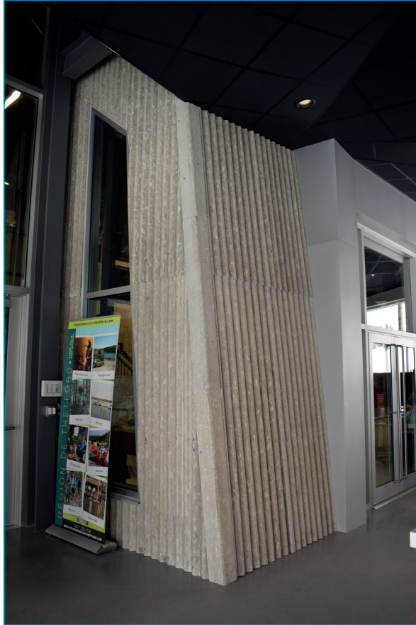
ILL. 13. PANNEAU EN FIBRES D'AMIANTE DANS LE VESTIBULE DU CENTRE KB3, 2022. SAMUEL DUBOIS & HEATHER BRAIDEN.
